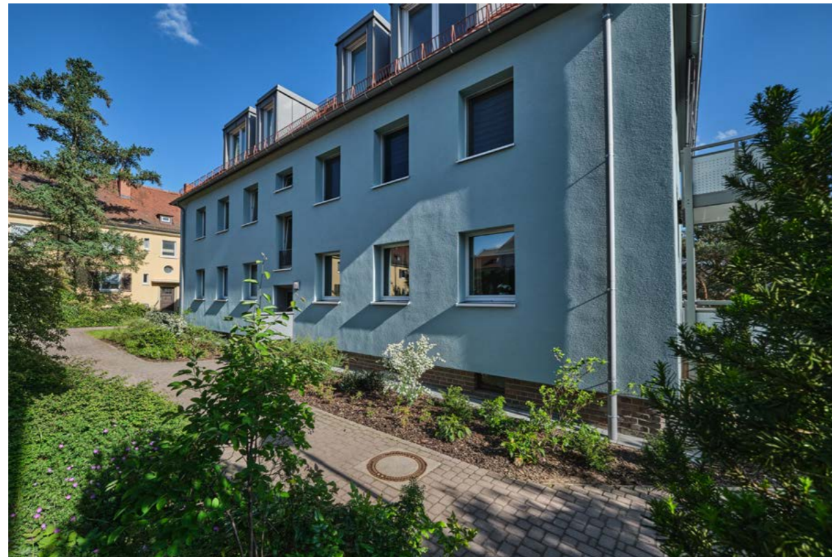
Hiltmannsdorfer Straße 76a – Ansicht Hauseingangsseite
