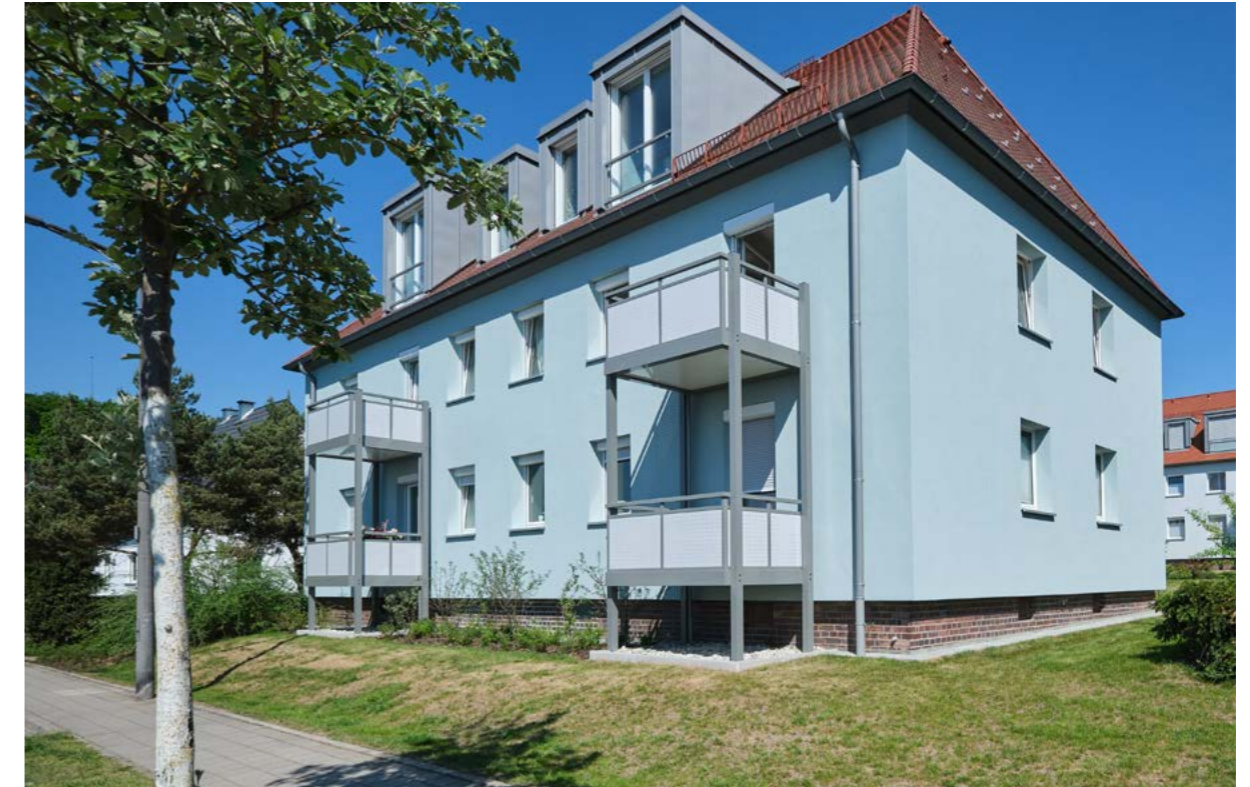
Hiltmannsdorfer Straße 76a – Ansicht von der Straße
