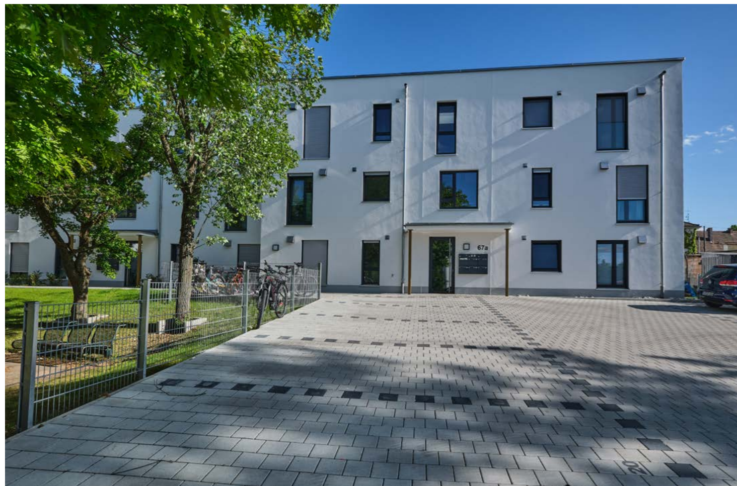
Neubau Volckamerstraße 67-67a – Vorderansicht
