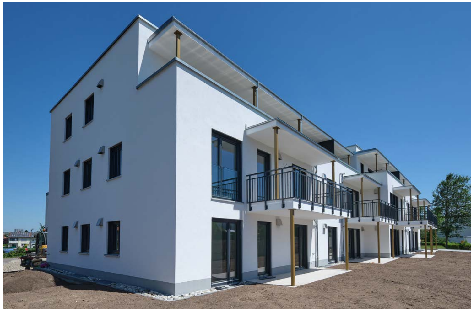
Neubau Volckamerstraße 67-67a
