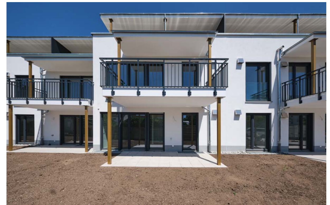
Neubau Volckamerstraße 67-67a
