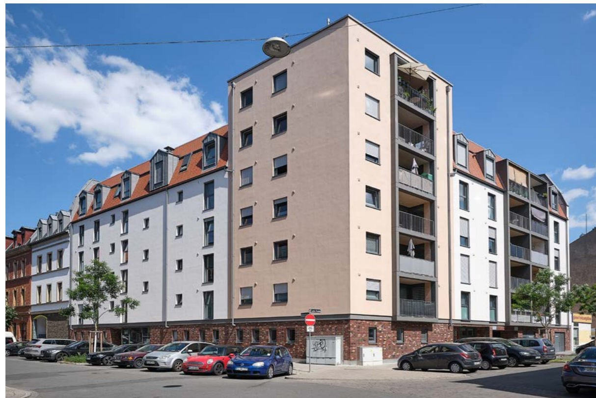
ARGE-Neubau Kaiserstraße 164/Leyher Straße 15
