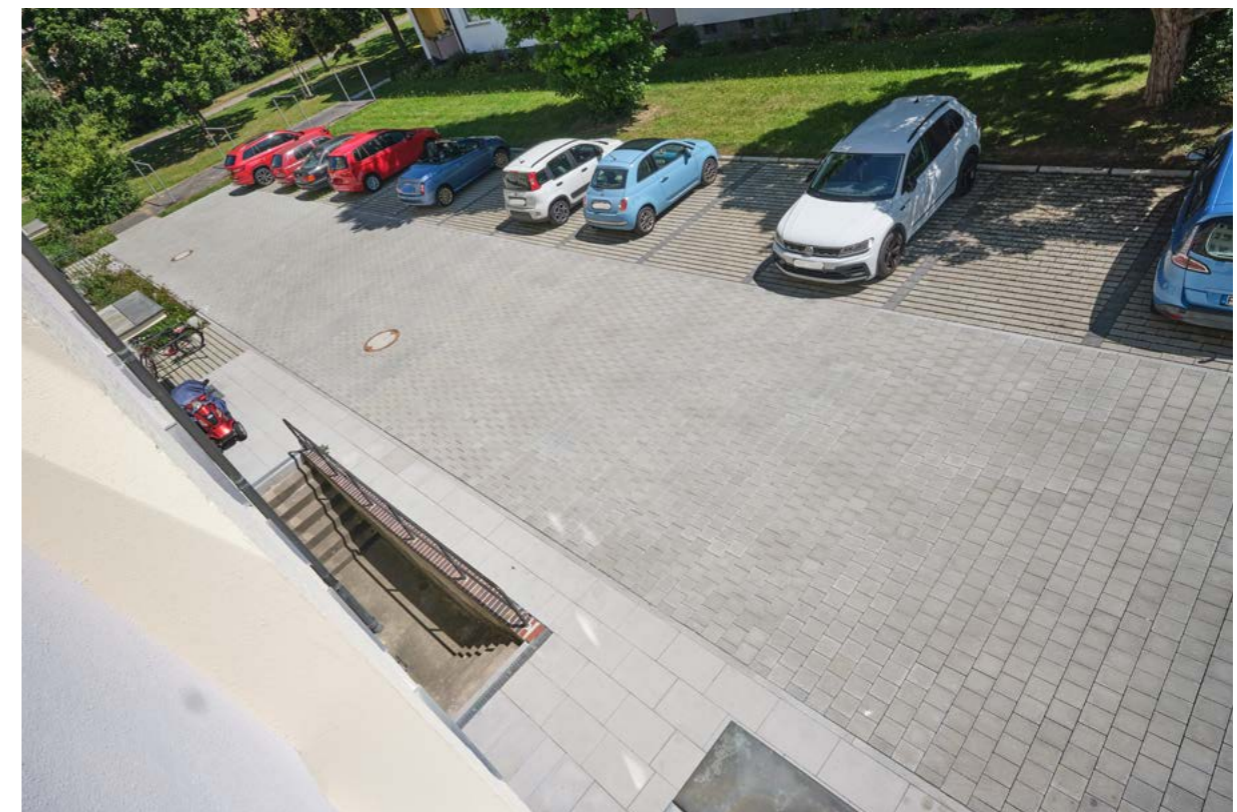
Bodenbacher Straße 6-8-10 (Erneuerung Parkfläche)
